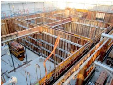
1階の型枠工事、コンクリートの打設工事が完了しました。
